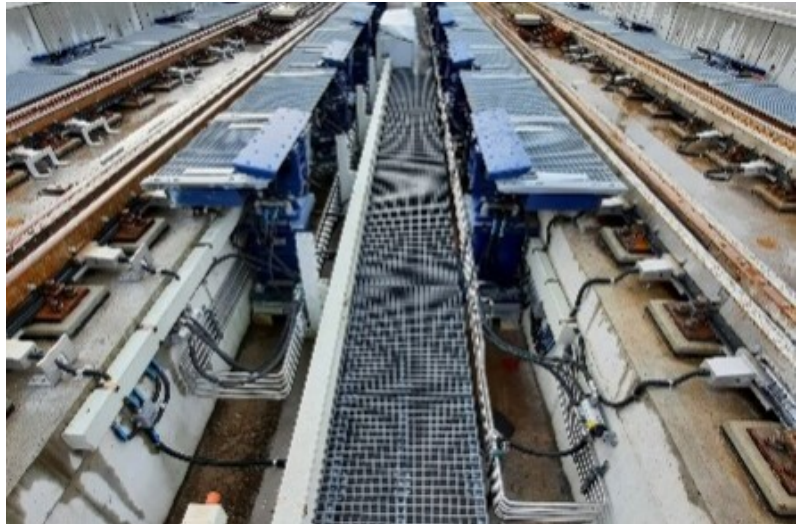
Umspuranlagen Gleis 6 und 7. Position BLS - Normalspur
