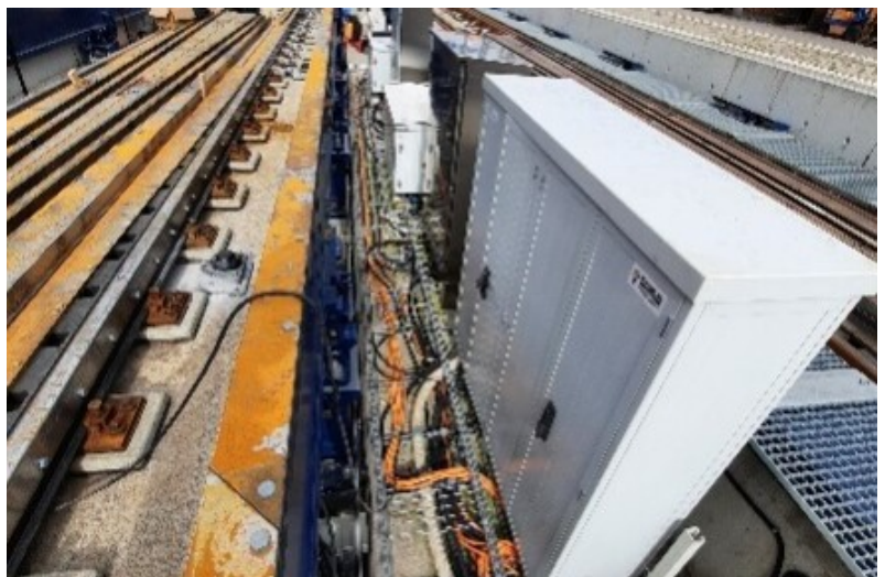
Installationsbereich zwischen den zwei Anlagen für die Steuerschränke der Energieversorgung, Heizung, Hydraulik und der Anlagensteuerung.
