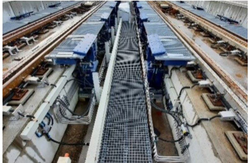
Vues des deux rampes à Zweisimmen, prêtes à l'emploi
