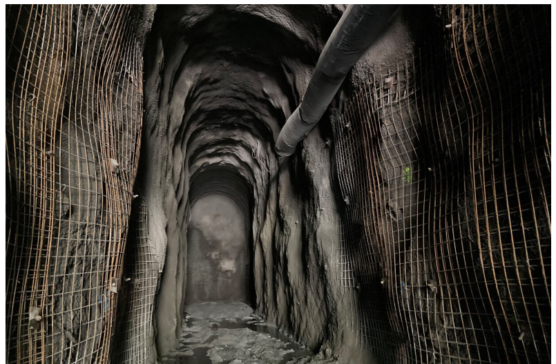
Erstellung Ausbruchsicherung im Sandfangstollen
