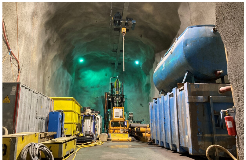
Schachtkopfkaerne mit Installationen Raise-Boring
