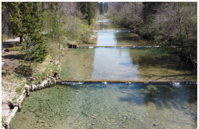
Ausgangszustand: Horizontale Holzschwellen, strukturalmes Gewässer
