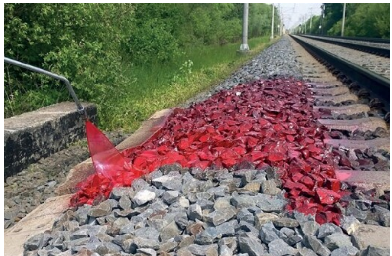
Oberflächenstabilisierung von Bahnschotter kann durch Färbung sichtbar gemacht werden
