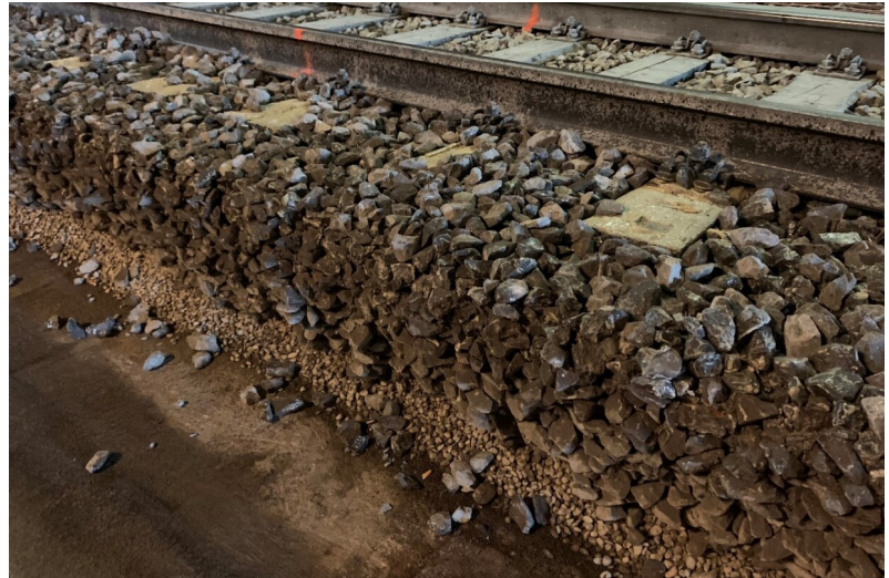
Vertikale Wand nach Verklebung mit Bahnbetrieb auf dem Bestandsgleis
