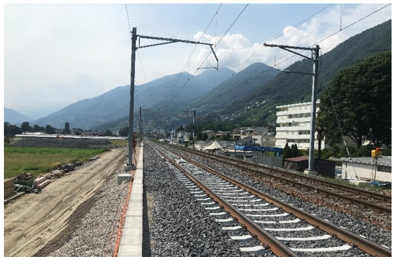
Gleis 100: Ansicht am Schluss der Arbeit mit der Linie in Betrieb
