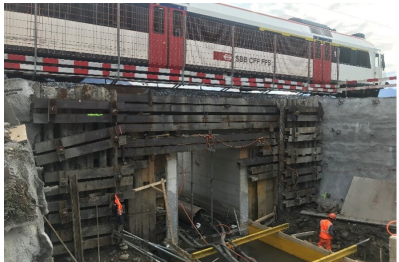
Baugrube für den Bau der Unterführung „Bollone“
