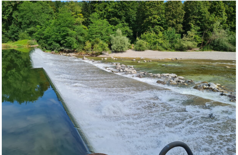
Bestehendes Wehr mit anschliessendem Prallboden, das durch ein fischschonendes Tosbecken ersetzt wird.
