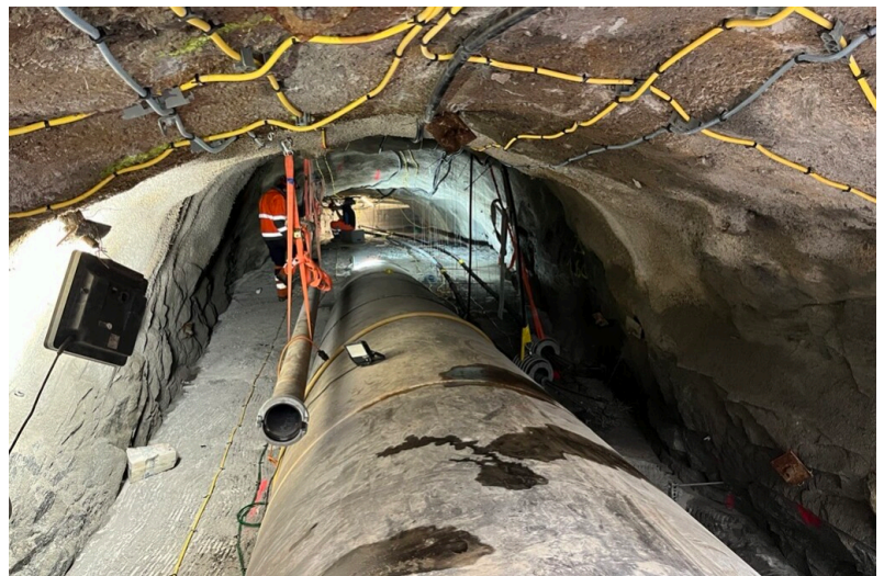
Montage Injektionsleitungen und Vorspannanker im Stollen der Flachstrecke
