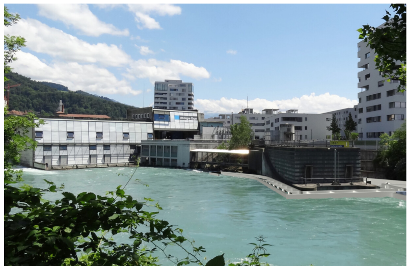
Visualisierung des Schlitzpasses (Ansicht vom Unterwasser)
