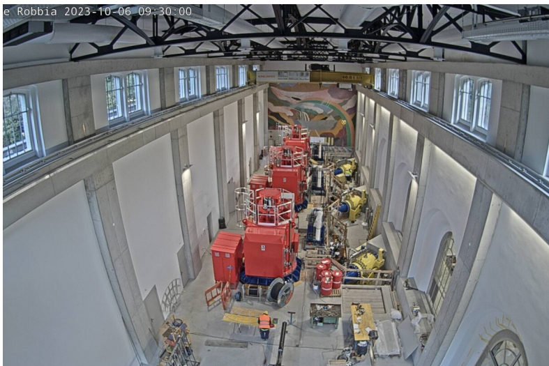
Montaggio condotte ad anello e alloggiamento delle turbine (foto WebCam cantieri)
