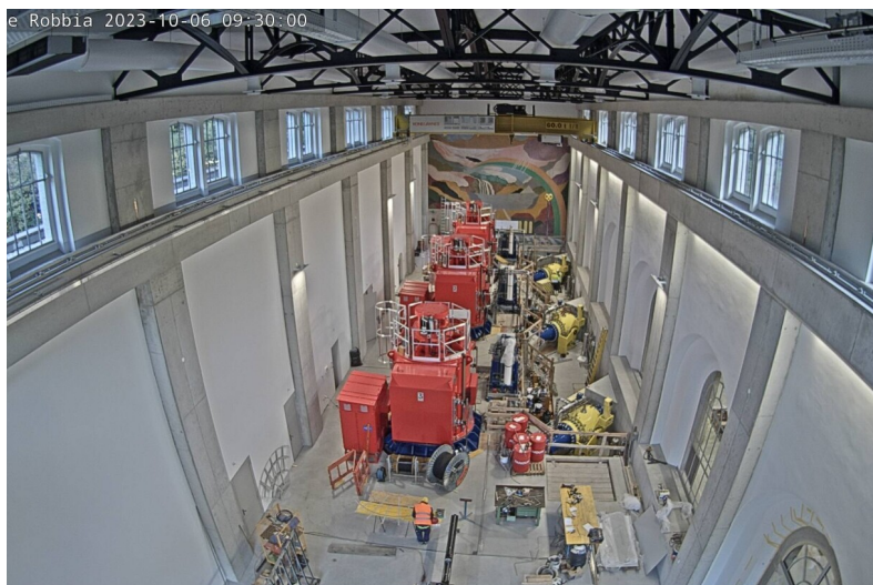
Montage des conduites circulaires et des corps de turbines (photo : webcam du chantier)
