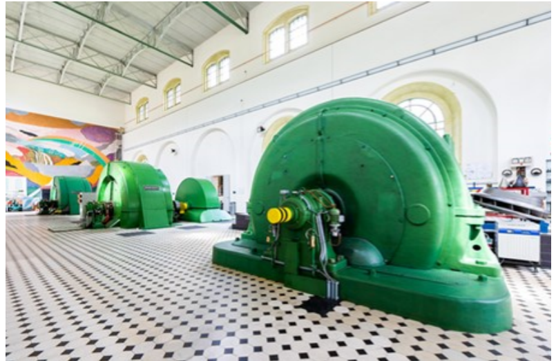
Ancienne centrale de Robbia, vue intérieure avant les travaux de transformation
