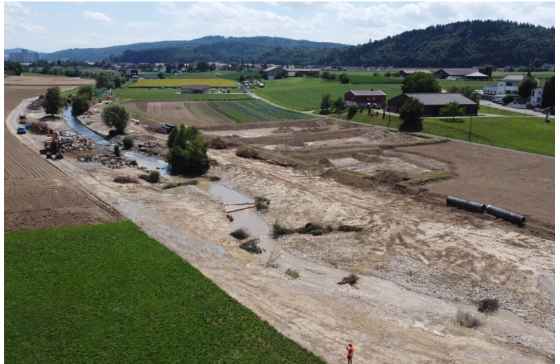
Blick in Gegenflussrichtung auf den untersten Abschnitt während der Bauarbeiten
