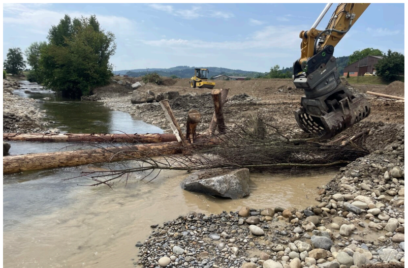
Einbau einer unterströmten Totholzstruktur zur Gerinnestrukturierung
