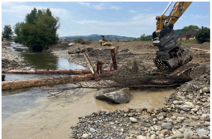
Einbau einer unterströmten Totholzstruktur zur Gerinnestrukturierung
