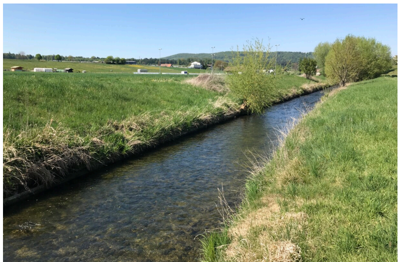
Das kanalisierte Gerinne der Bünz im Ausgangszustand
