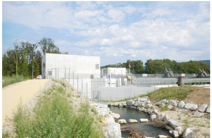
Vue extérieure de la centrale de dotation côté UW avec dispositif de remontée des poissons (passe à fentes/passage dans le bassin du Rauger)
