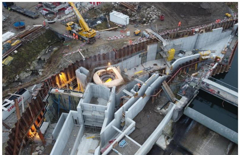
Fouille de la centrale de dotation avec dispositif de montée et de descente des poissons, travaux de bétonnage et levage du cône
