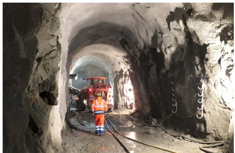
Galeries d'accès Chambre d'appareillage Agneau d'hôpital
