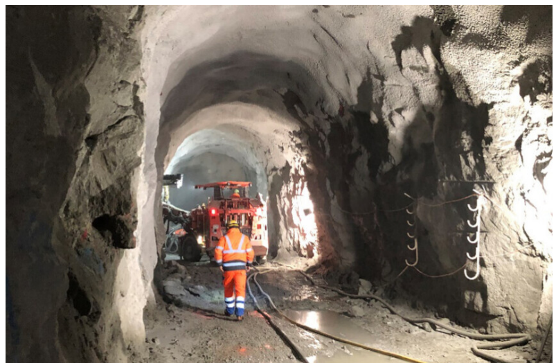
Galeries d'accès Chambre d'appareillage Agneau d'hôpital
