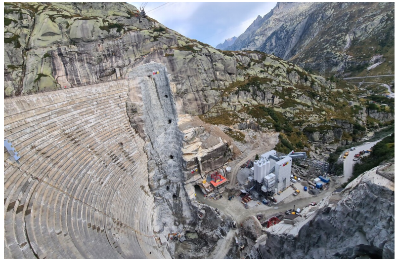
Poste d'installation de l'agneau d'hôpital
