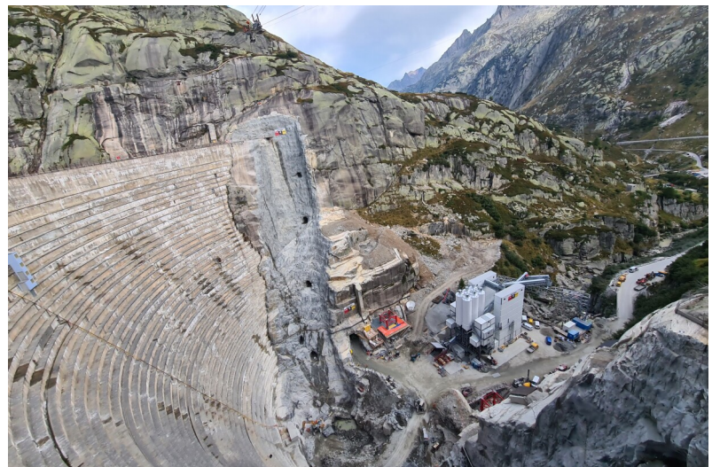
Poste d'installation de l'agneau d'hôpital
