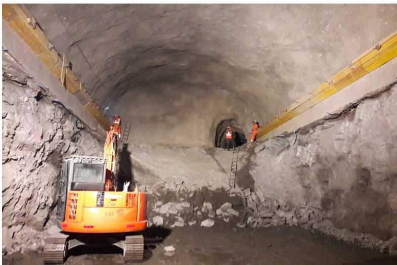
Scavo della caverna della macchina
