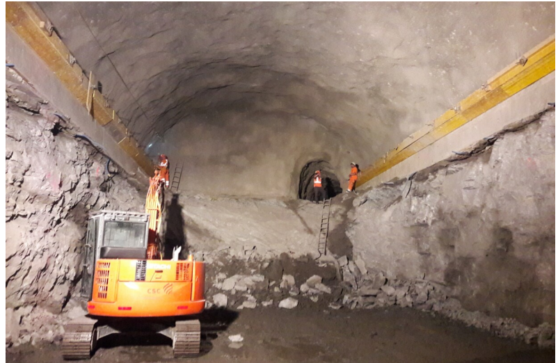
Scavo della caverna della macchina
