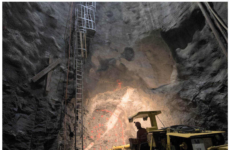
Abteufen des Schachts und Beginn Vortrieb Unterwasserstollen
