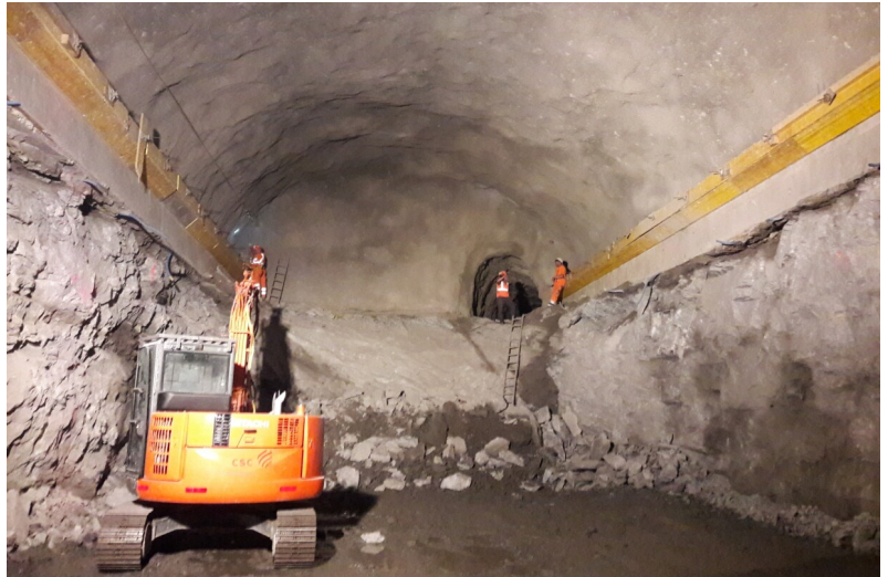
Ausbruch der Maschinenkaverne
