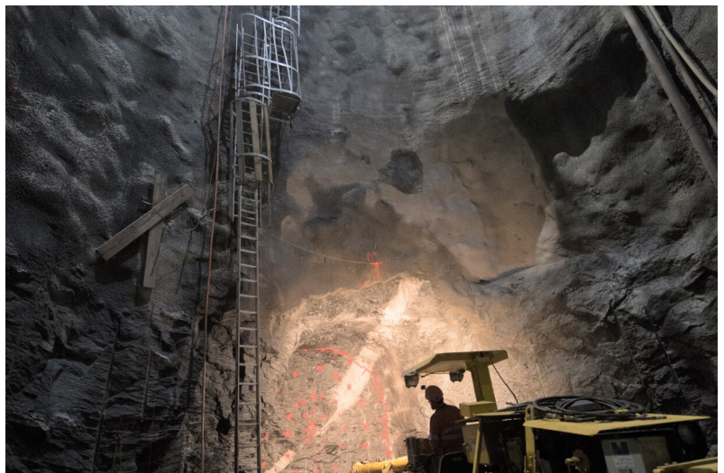
Abteufen des Schachts und Beginn Vortrieb Unterwasserstollen
