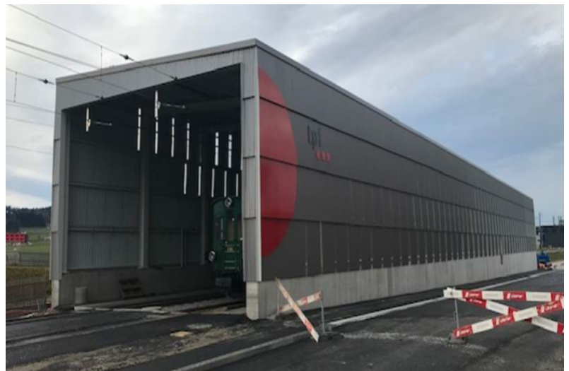
Nouveau couvert de voies
