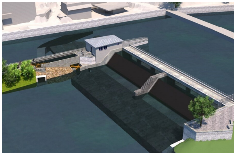
Visualisierung des neuen Wehrrs und des mäandrierenden Fischpasses
