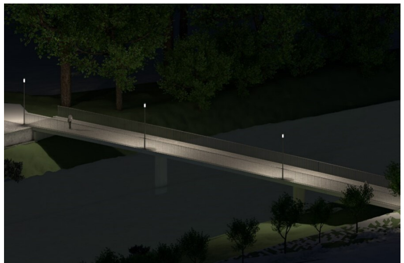
neue Platzspitzbrücke als Zugang zum Wehr
