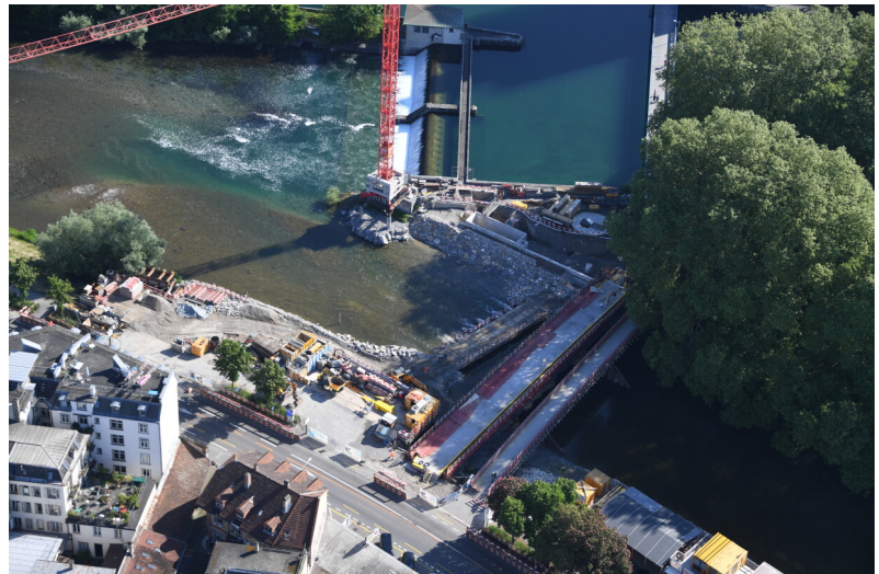
Arbeiten am Wehr
