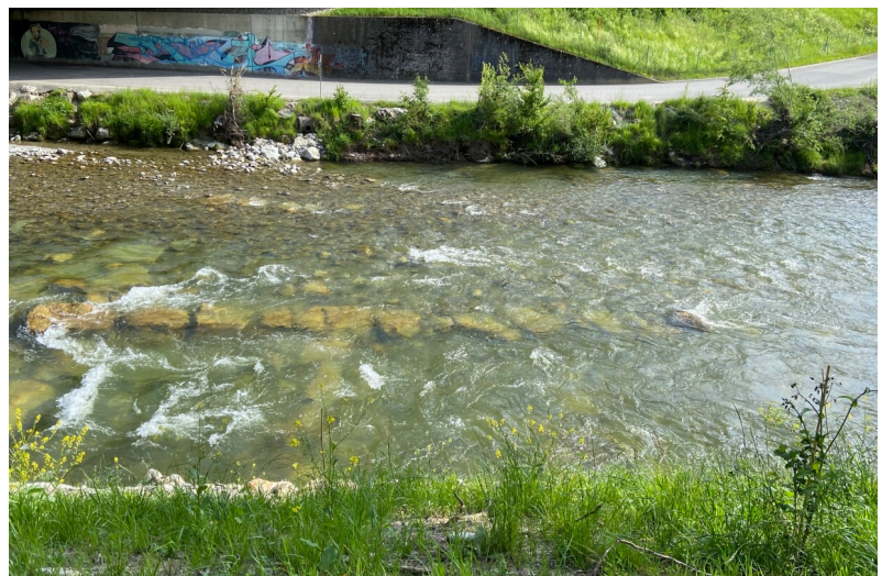
Dreigeteilte, fischgängige Rampe (Grossteils noch überschüttet)
