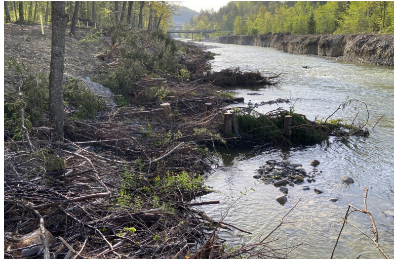
BMU und Baumbuhnen rechtsufrig, Aufweitung linksufrig; Blick gegen Fließrichtung
