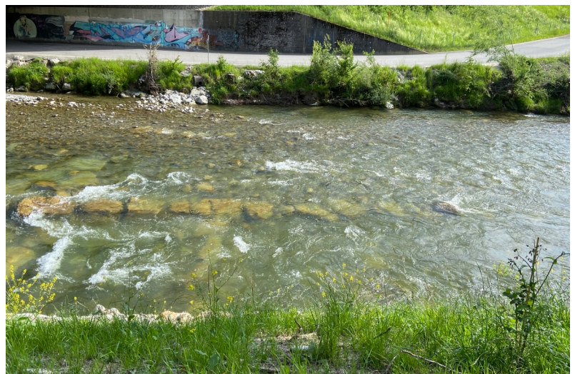
Dreigeteilte, fischgängige Rampe (Grossteils noch überschüttet)
