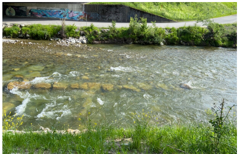
Rampe divisée en trois parties et franchissable par les poissons (encore comblée en grande partie)
