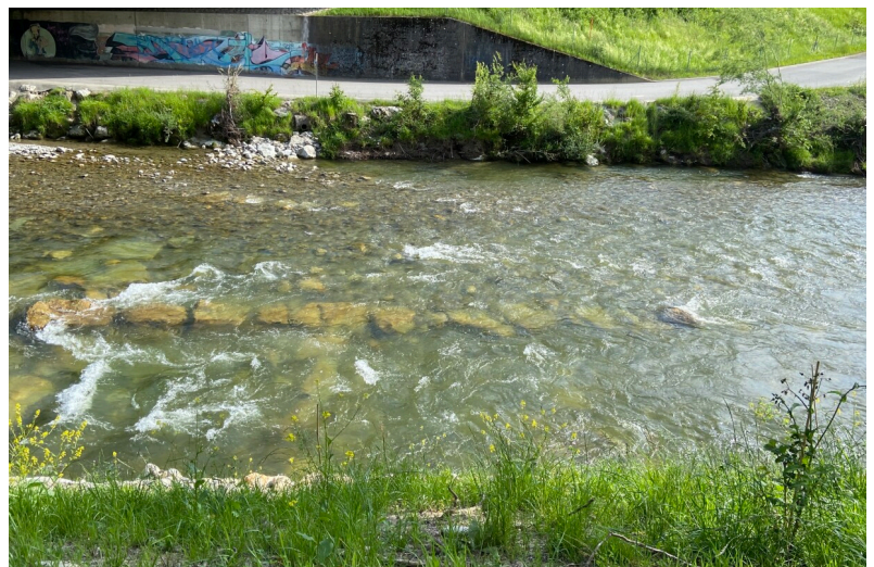
Rampe divisée en trois parties et franchissable par les poissons (encore comblée en grande partie)
