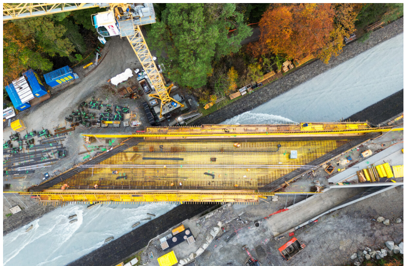
Costruzione del nuovo ponte di Schächen
