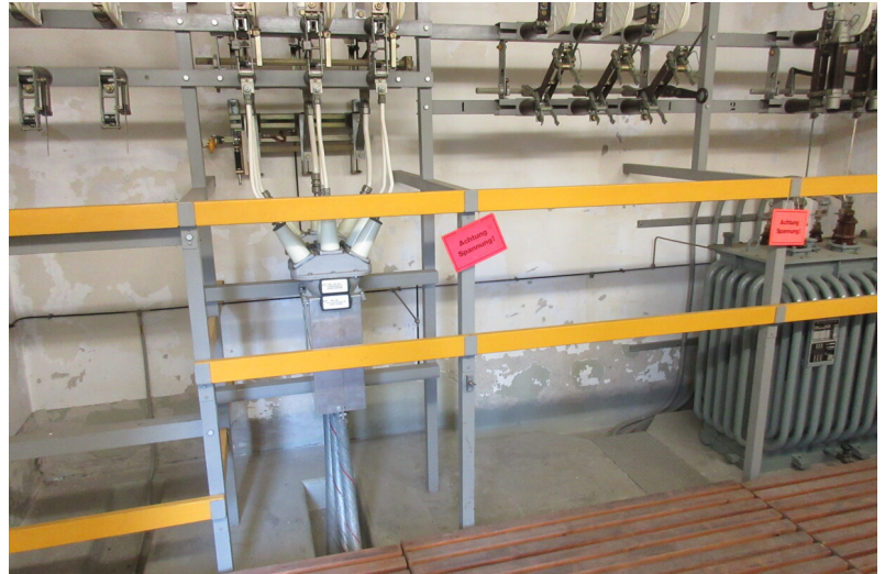
Trafostation Brunnadernrain vor der Sanierung
