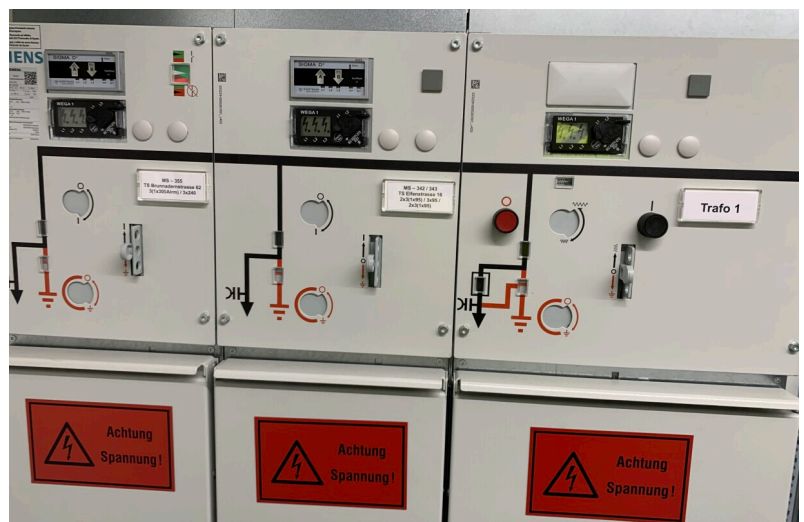
Trafostation Brunnadernrain nach der Sanierung
