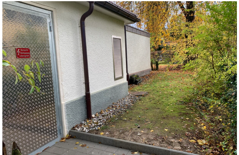
Trafostation Brunnadernrain nach der Sanierung
