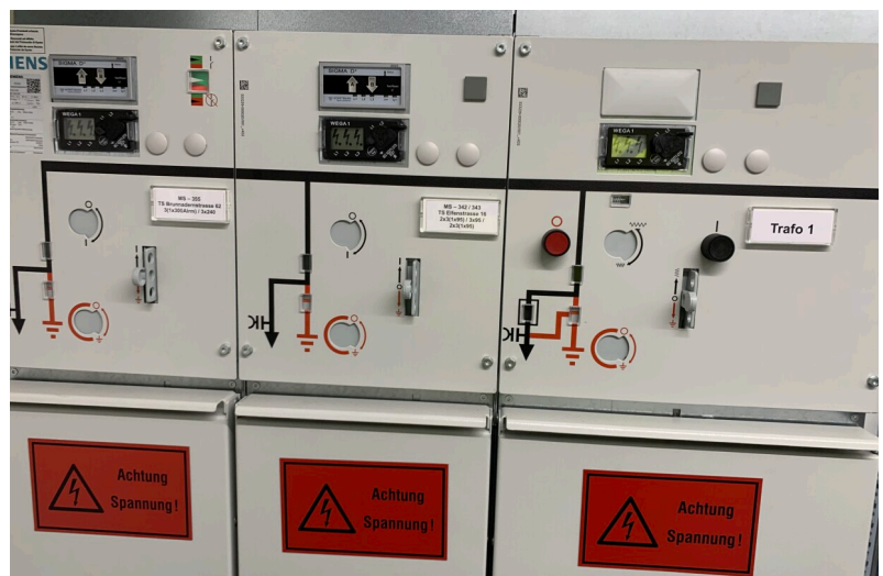
Trafostation Brunnadernrain nach der Sanierung
