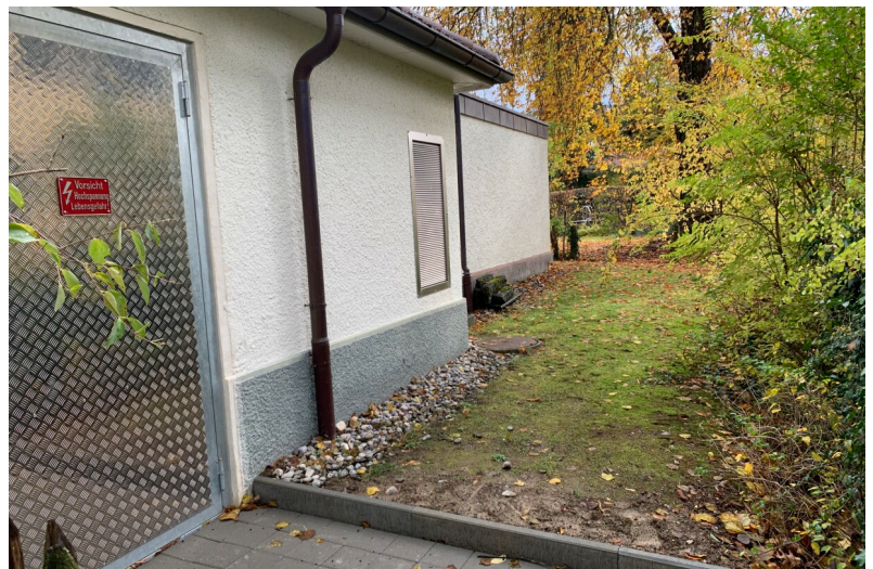
Poste de transformation Brunnadernrain après la rénovation
