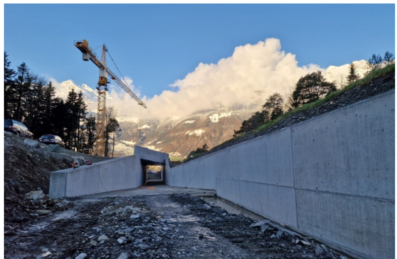
neuer Hochwasserdurchlass Schächenmatt
