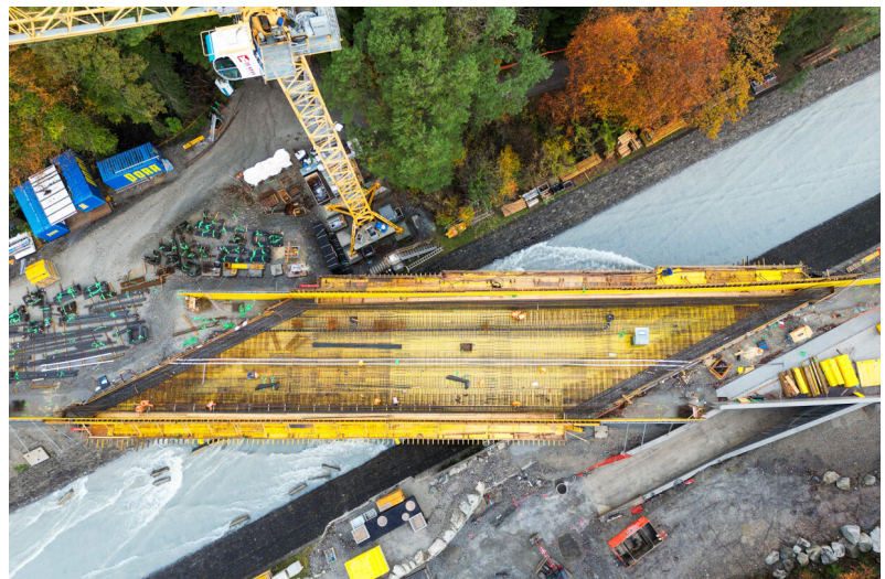
Bau der neuen Schächenbrücke
