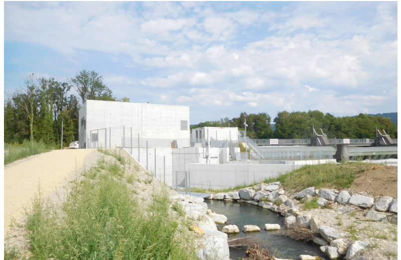
Aussenansicht Dotierkraftwerk UW-seitig mit Fischaufstiegshilfe (Schlitzpass/Raugerinnebeckenpass)
