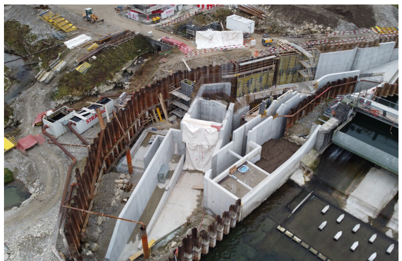
Baugrube Dotierkraftwerk mit Fischauf- und -Abstiegshilfe, Betonarbeiten und Einheben Konus
