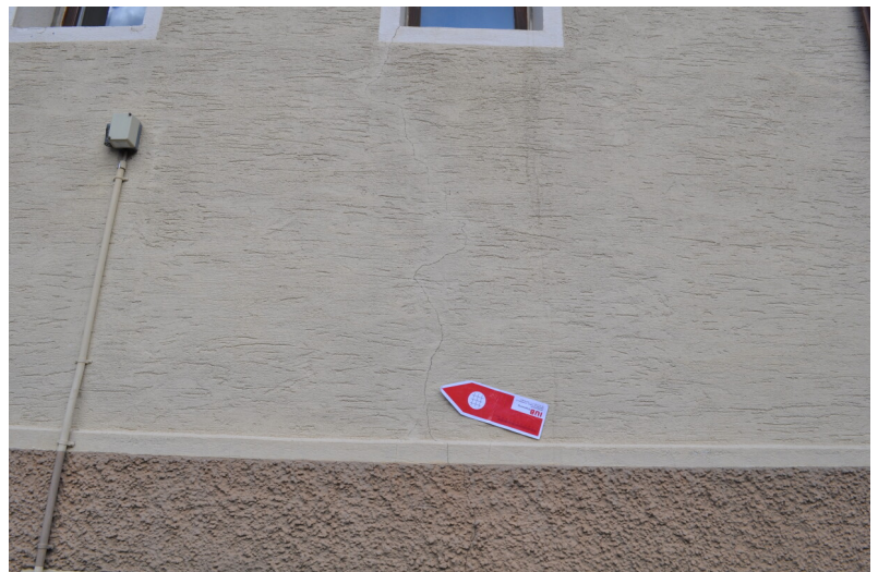
Riss in Fassade, mit Markierpeil
