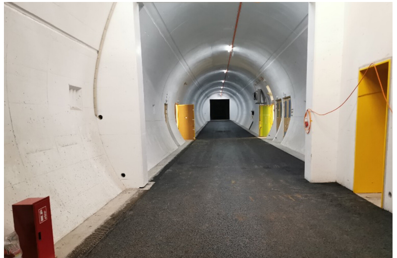
Querverbindung STB – bestehende Röhre, 21.11.2019
