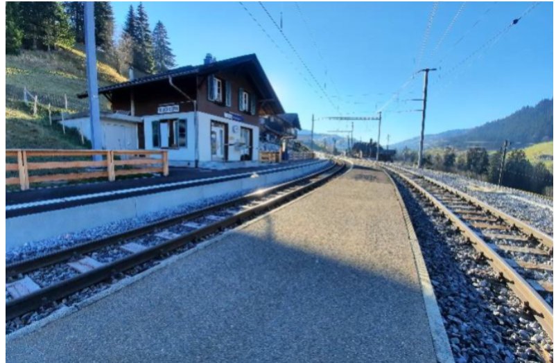
Gare d'Oeschseite-état final
