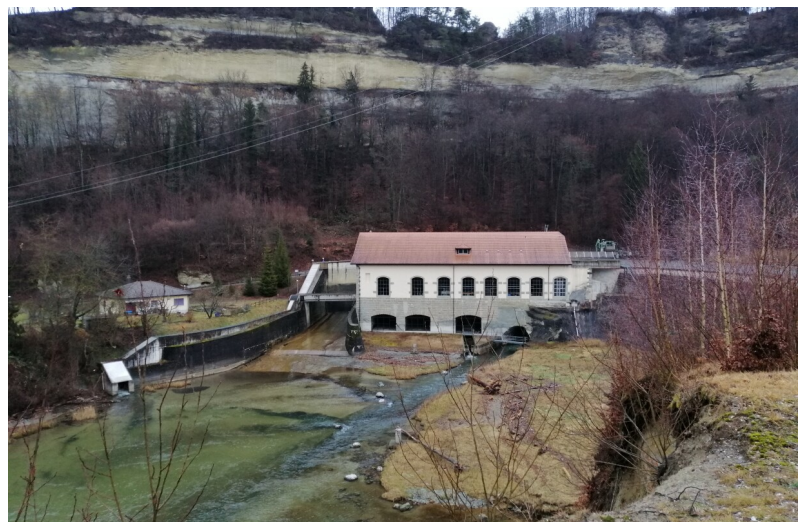
Staumauer von Maigrage - Anfangszustand
