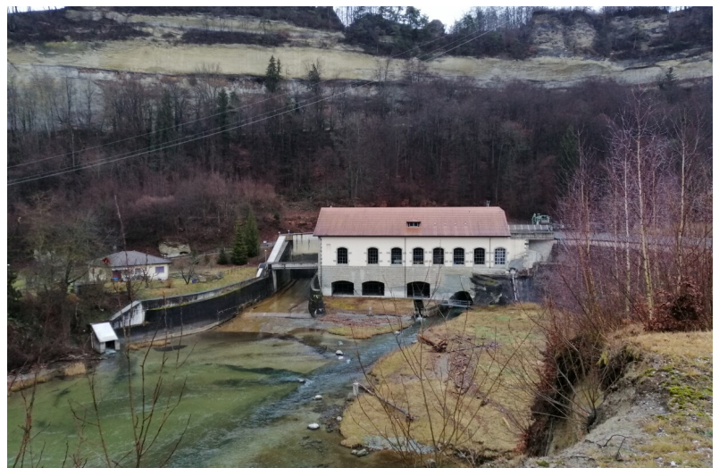
Barrage de la Maigrauge - Etat initial
