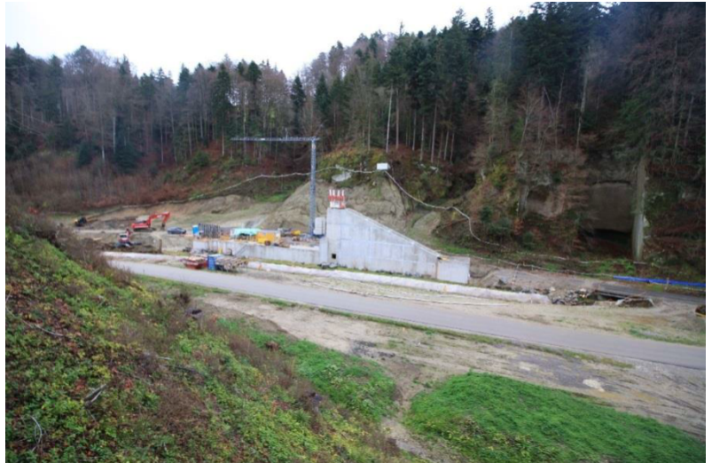
Durchlassbauwerk während dem Bau
