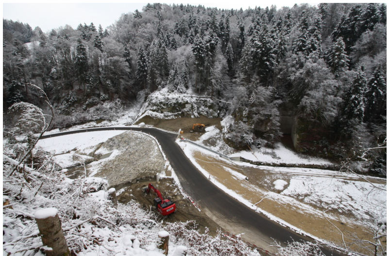
Fertiggestelltes Hochwasserrückhaltebecken inkl. neuer Luterbachstrasse
