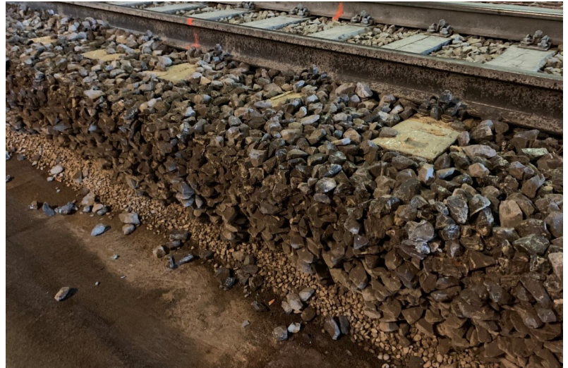
Parete verticale dopo l'incollaggio con l'esercizio ferroviario sul binario esistente
