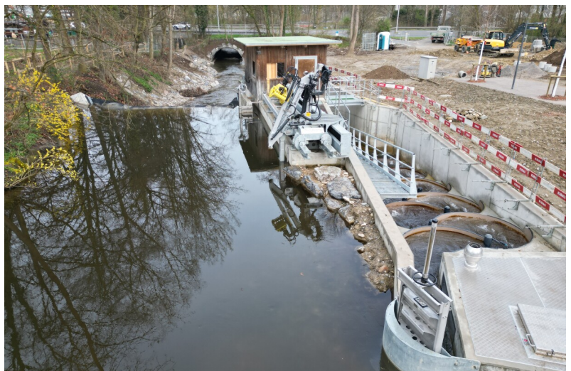
KW Sursee mit neuem Horizontalleitrechen-Bypass-System und Mäanderfischpass
