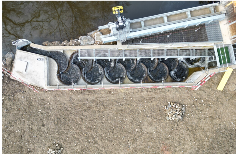
Neuer Mäanderfischpass (Kombination C-Typ & J-Typ) am KW Sursee
