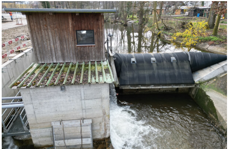
Blick vom Unterwasser auf das neue Schlauchwehr mit Konturmembran
