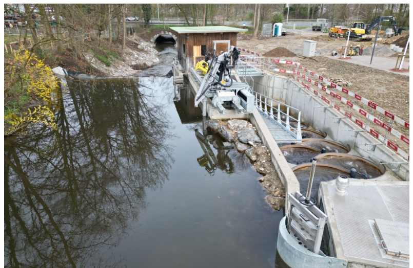
KW Sursee mit neuem Horizontalleitrechen-Bypass-System und Mäanderfischpass
