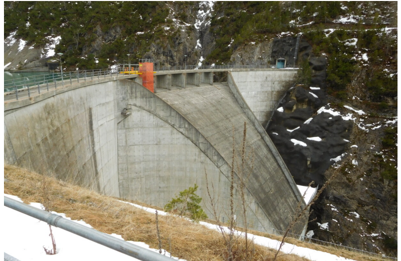
Centrale d'Ova Spin (intégrée au barrage)
