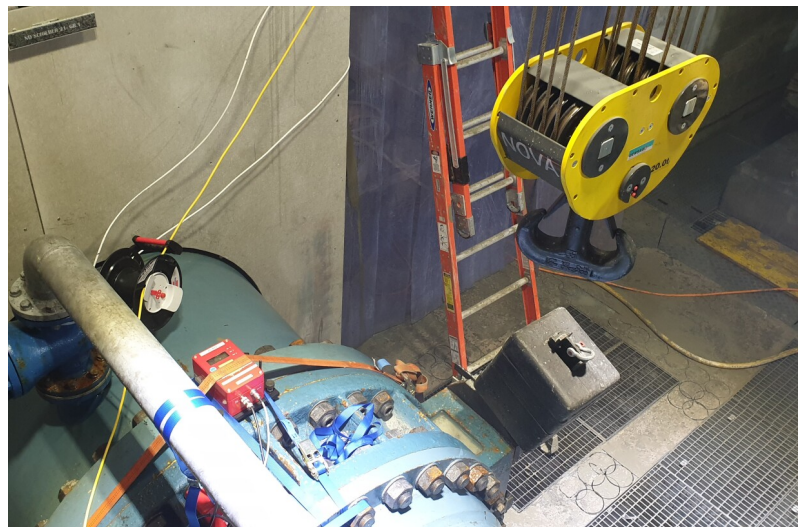
Erschütterungsmessgerät montiert auf der Drosselklappe Maschinengruppe 1
