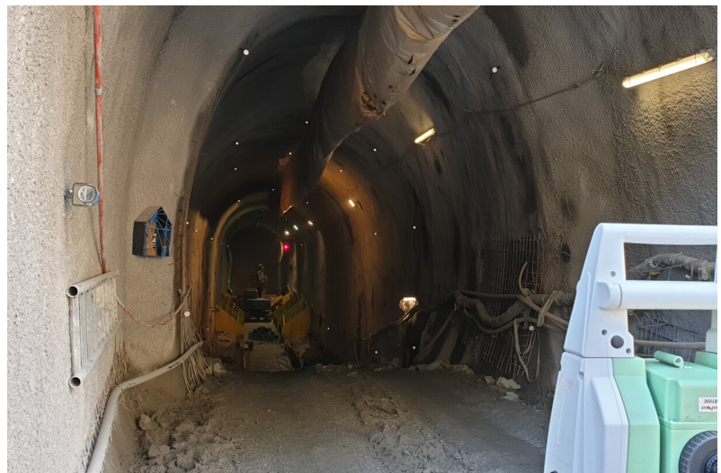
Verformungsmessung Tunnelgewölbe
