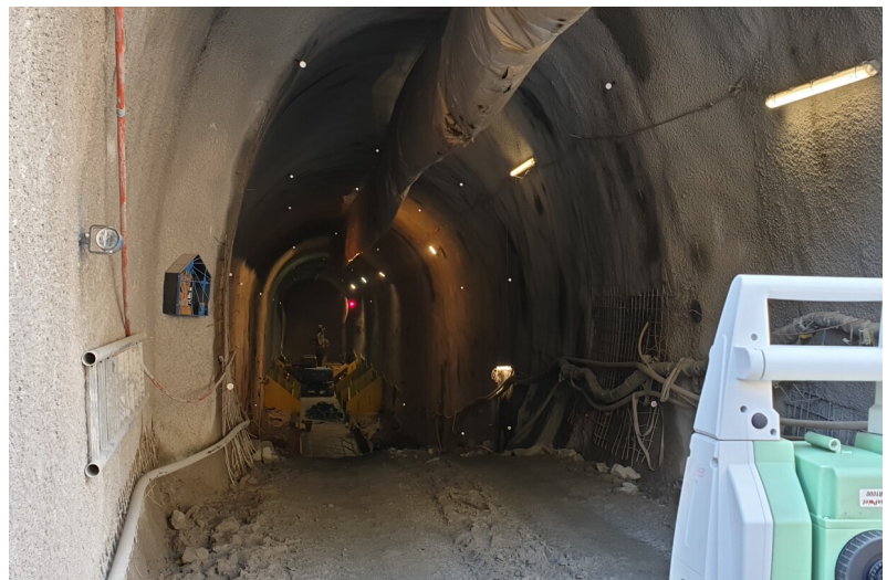
Verformungsmessung Tunnelgewölbe
