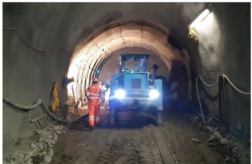
Ortsbrust mit Anbringen der Gewölbeseicherung
