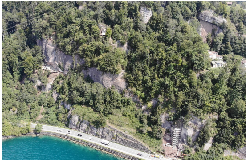
Projektperimeter Sparen mit Nagelfluh-Felsbändern und Massnahmen im Bau
