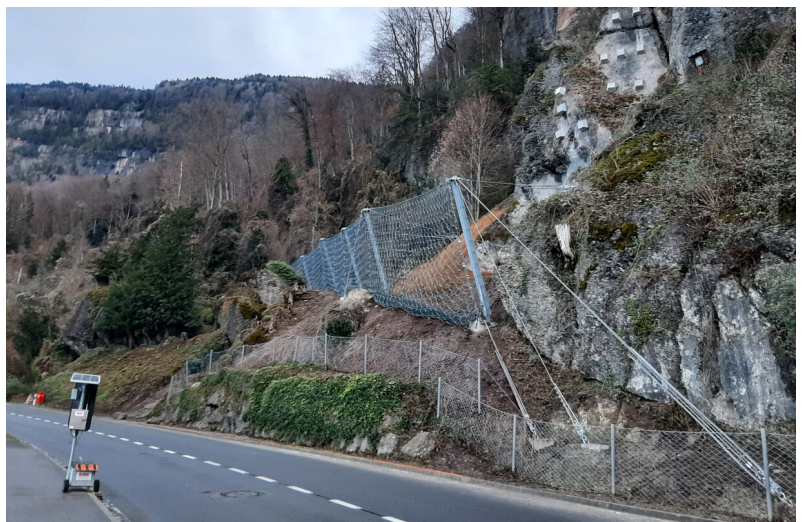
Steinschlagschutznetz 3'000kJ und Sicherungsmassnahmen mit Ankern
