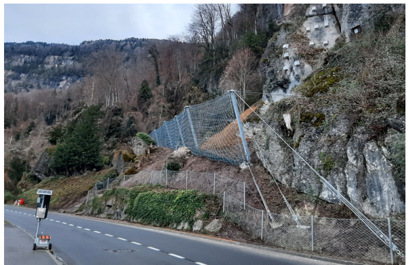
Steinschlagschutznetz 3'000kJ und Sicherungsmassnahmen mit Ankern
