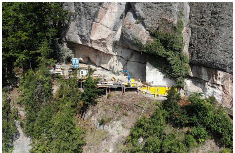
Installationen bei einem Felsobjekt für Ankerarbeiten und Betonkonsolen
