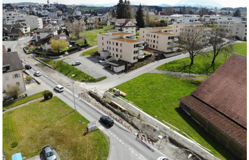
Luftbild der ersten Ausführungsstufe mit offenem Graben für Regenabwasserleitung
