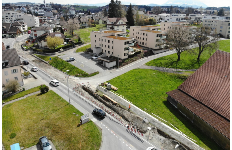
Luftbild der ersten Ausführungsphase mit offenem Graben für Regenabwasserleitung
