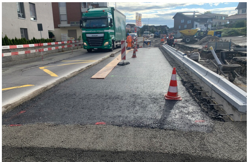
Eingebaute Tragschicht für Bushaltestelle mit Sonderbordstein (BehiG)
