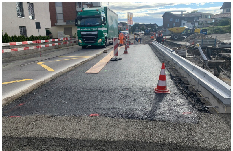
Eingebaute Tragschicht für Bushaltestelle mit Sonderbordstein (BehiG)
