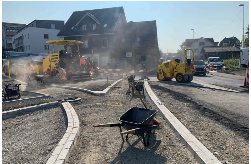
Belageinbau Knoten Sempachstrasse / Siedereistrasse
