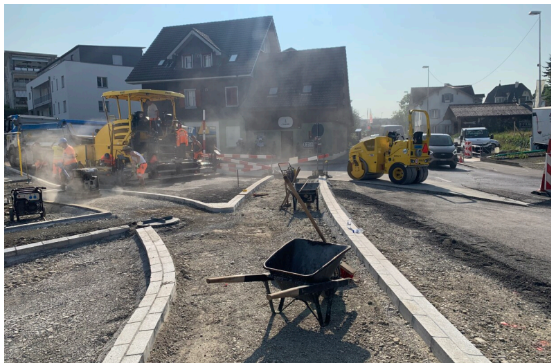
Belageinbau Knoten Sempachstrasse / Siedereistrasse
