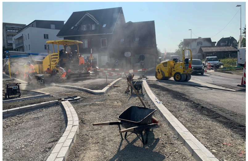
Belageinbau Knoten Sempachstrasse / Siedereistrasse
