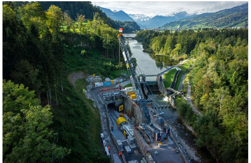
Montage der Tunnelbohrmaschine vor dem künftigen Auslaufbauwerk vor dem aufgestauten Wichelsee
