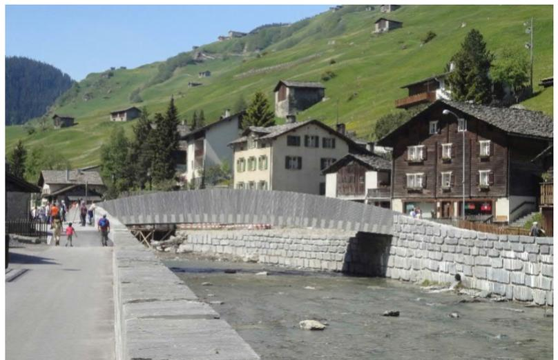
Bau neuer Ufermauern zur Erhöhung der Gerinnekapazität und Bau einer neuen Strassenbrücke im Ortskern
