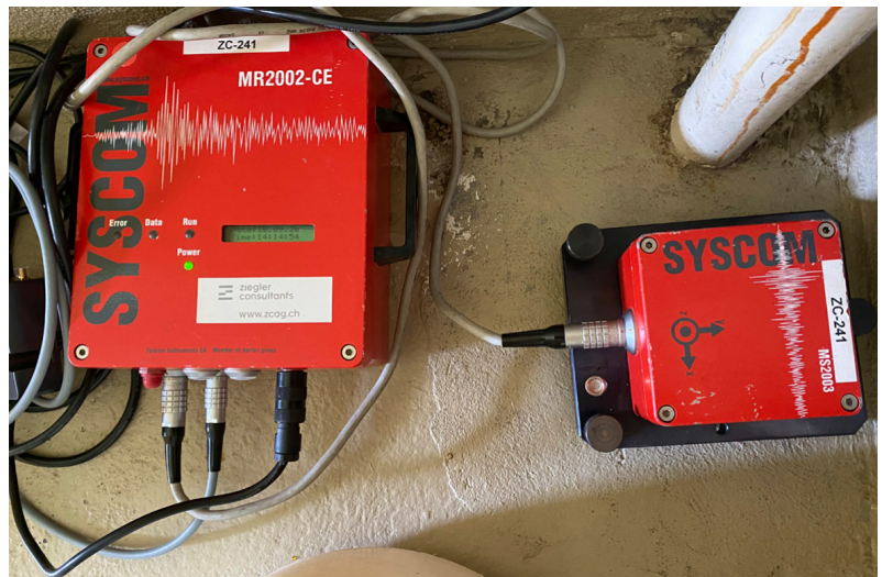
Erschütterungsmessgerät in Gebäudekeller
