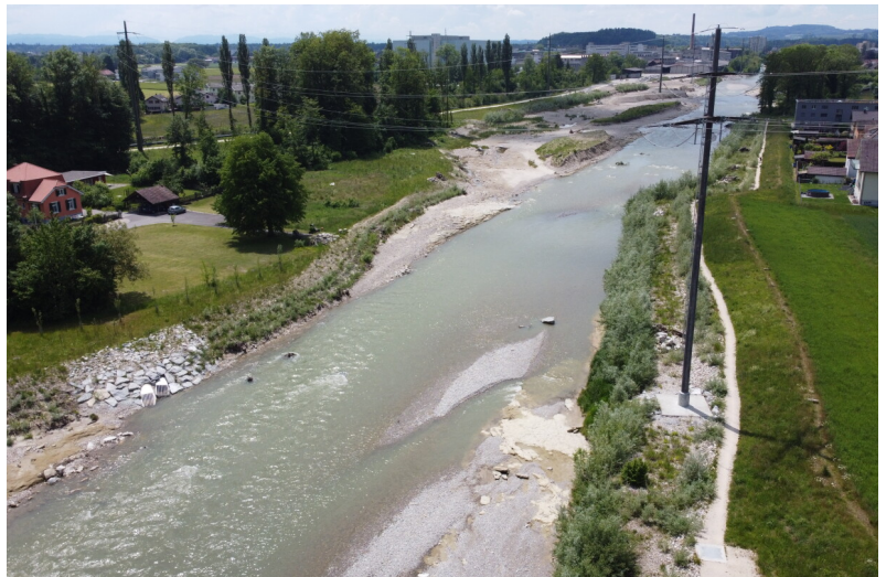
Vordergrund: Gerinneverbreiterung und ingenieurblogische Ufergestaltung; Hintergrund: Überflutungsfläche Papieri
