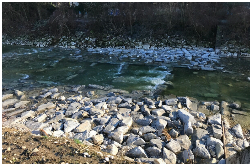
Fischgängige Rampe mit Riegel-Becken-Struktur
