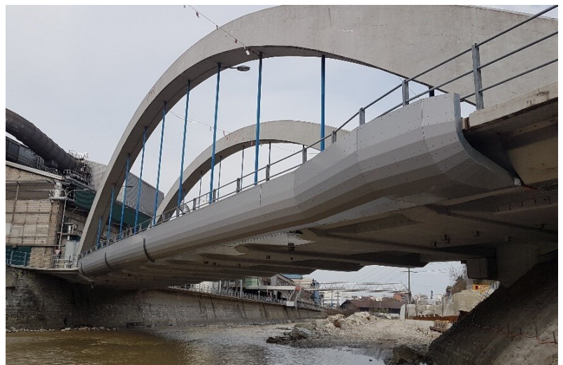
Brückenverschalung zur Minimierung der Verklausungsgefahr
