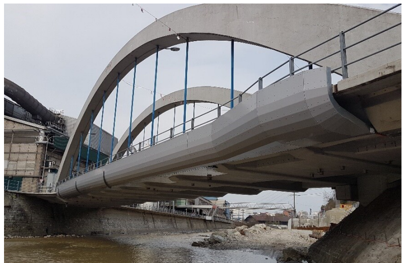
Brückenverschalung zur Minimierung der Verklausungsgefahr
