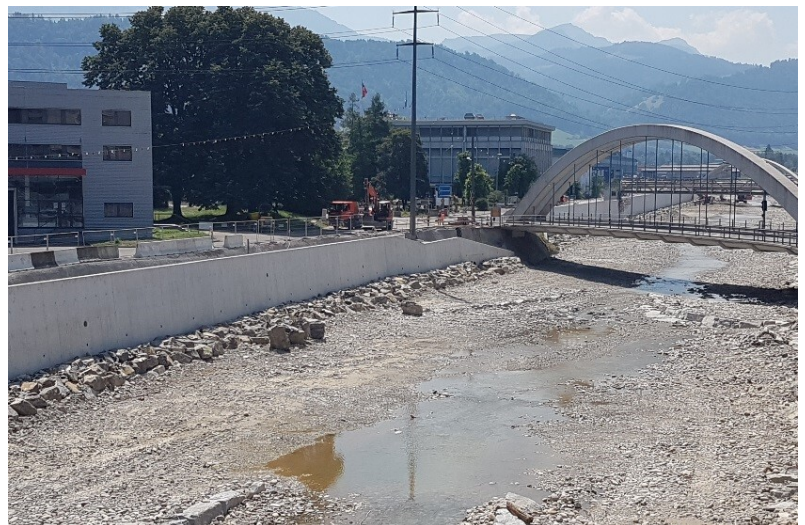
Verbreitertes Gerinne mit neuer Ufermauer und strukturierenden Massnahmen im Gerinne
