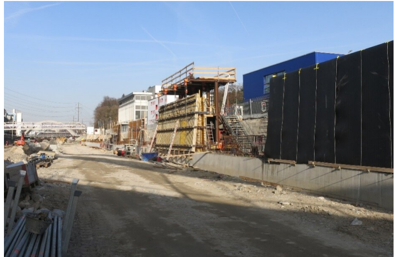
Erstellung der neuen Ufermauer
