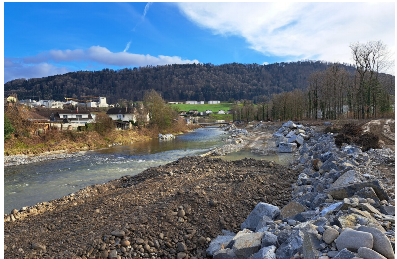
Linksufrige Aufweitung Etappe 2 (Blick gegen Fliessrichtung)
