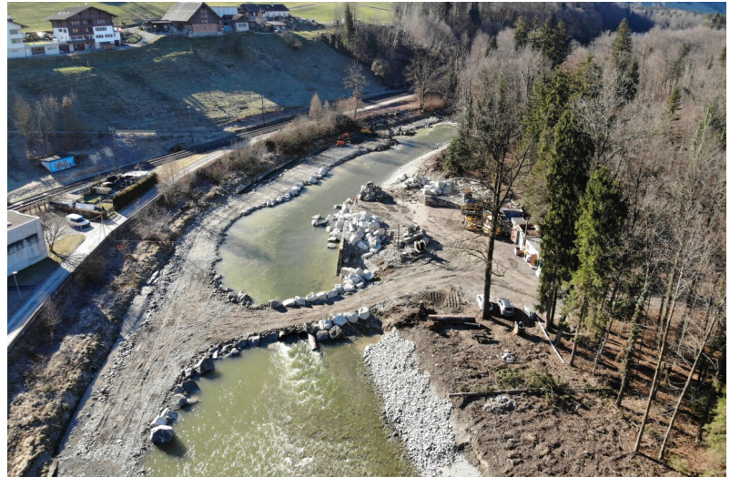
Baustelleninstallationen inkl. Baupisten im Gewässer Etappe 1
