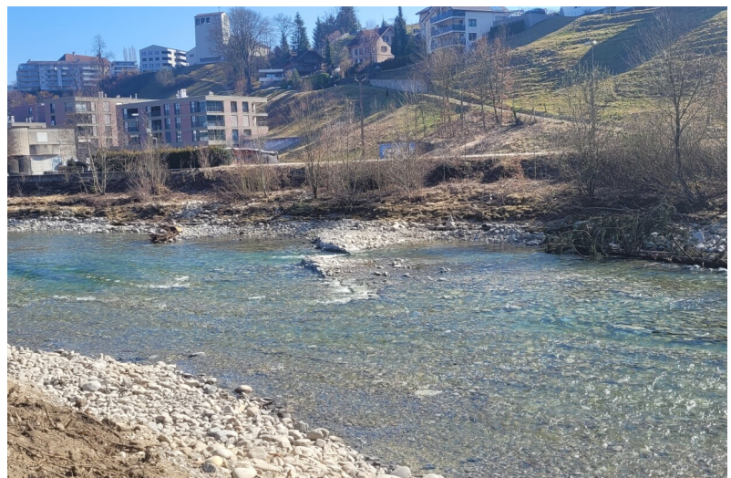
Strukturmassnahmen im Gerinne Etappe 1
