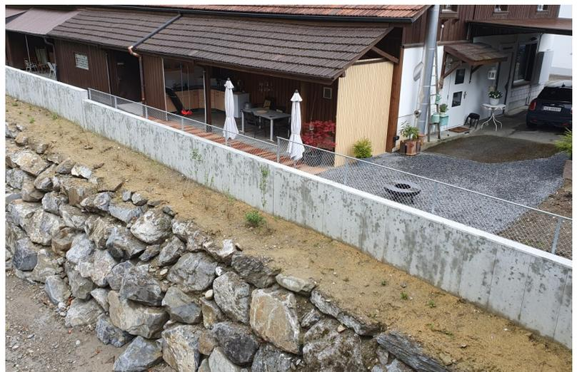
Blocksatz mit aufgesetzter Winkelstützmauer
