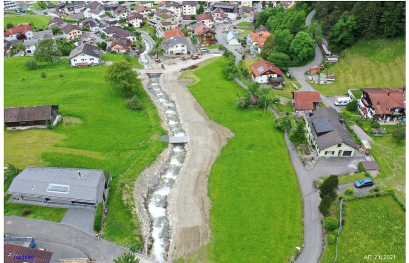
Neubau Gerinne mit Riegel-Becken-Struktur (Foto: AFT Kt. Uri)
