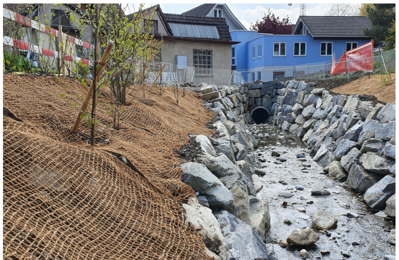
Einlaufbereich des eingedolten Bachleitung
