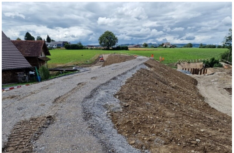
Dammkrone mit überdecktem Erosionsschutz
