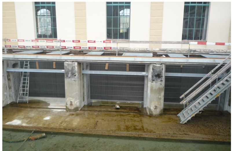
Fischzählbecken im Oberwasser
