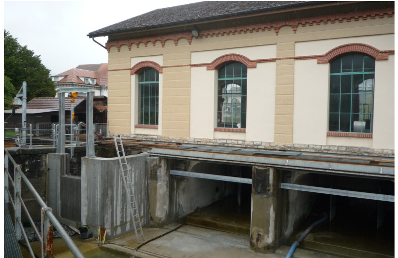
Fischzählbecken im Oberwasser
