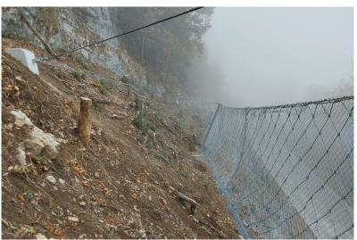
Abtrag zerklüfteten Felskopf während dem Bau
