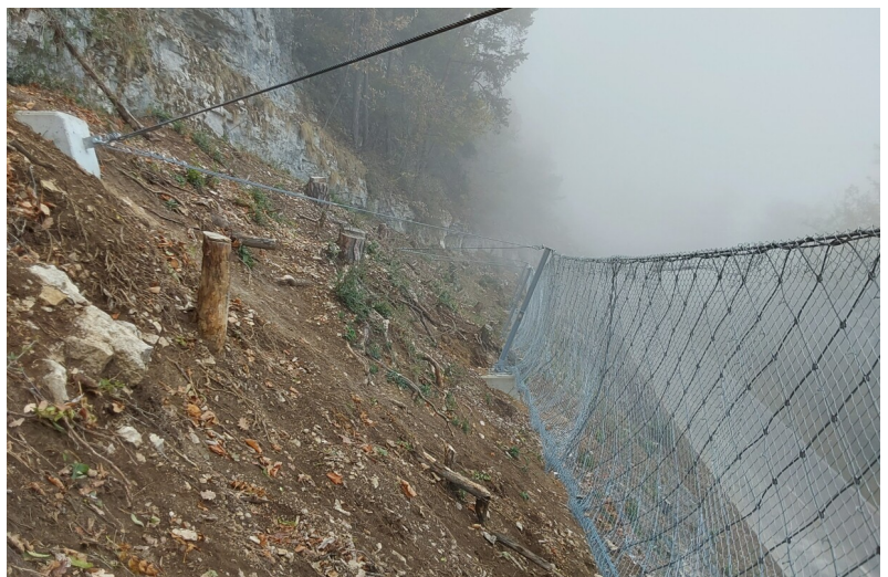
Abtrag zerklüfteten Felskopf während dem Bau
