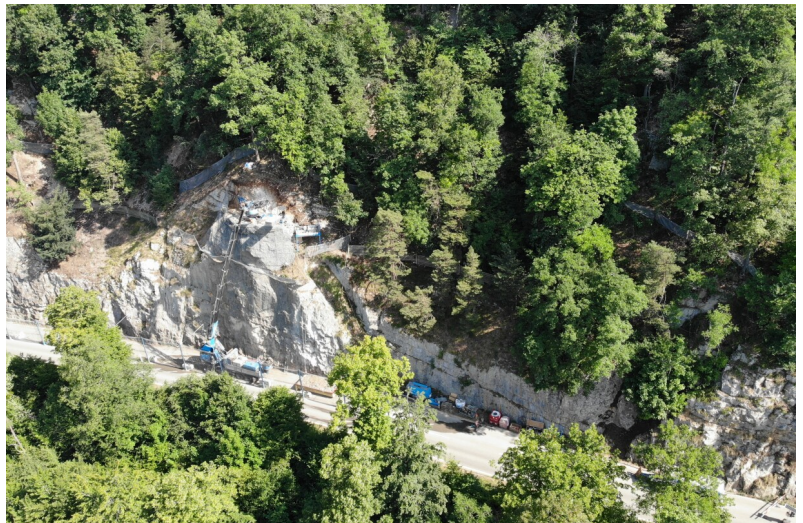
Abtrag zerklüfteten Felskopf während dem Bau
