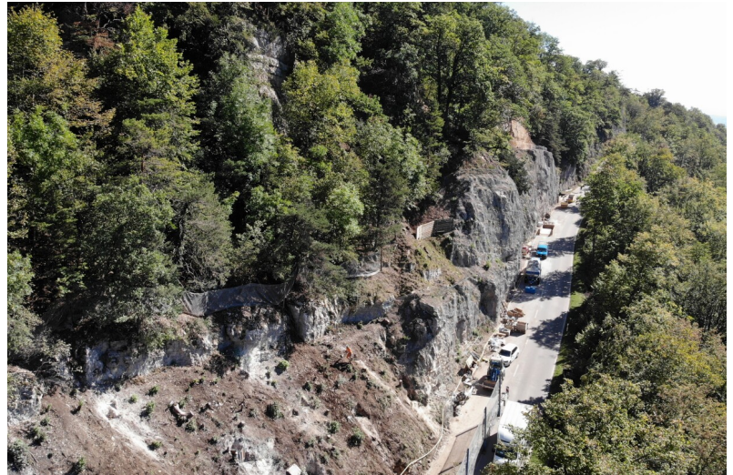
Projektperimeter Hauensteinstrasse mit anstehenden Felswänden
