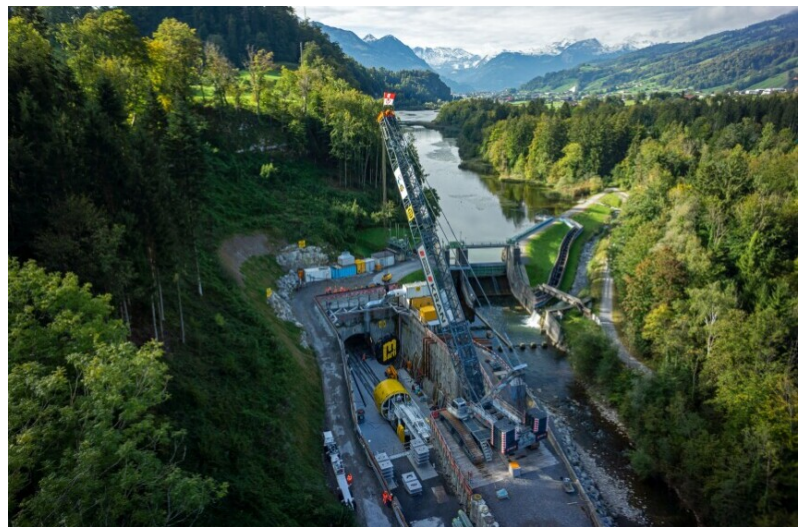
Montage du tunnelier devant le futur ouvrage de sortie devant le lac de Wichel endigué
